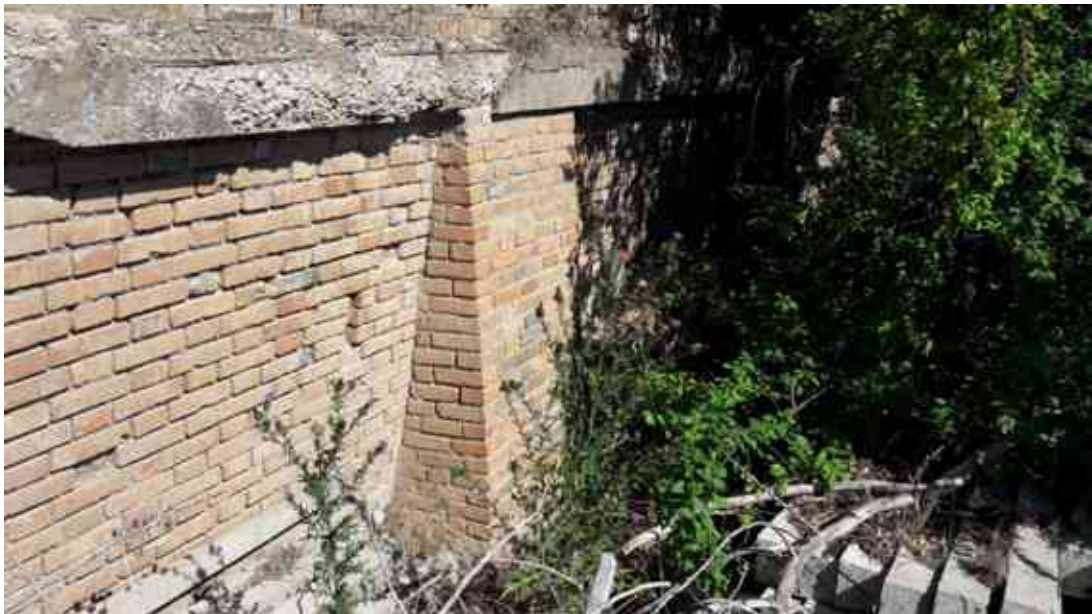
FOTO 42 – Porzione di muro di contenimento visibile tra la vegetazione ed i tralci di vigneto
