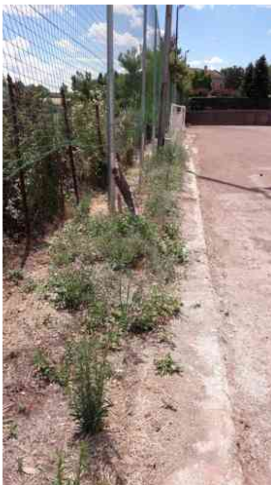
FOTO 67 – Lato nord area campo da gioco
