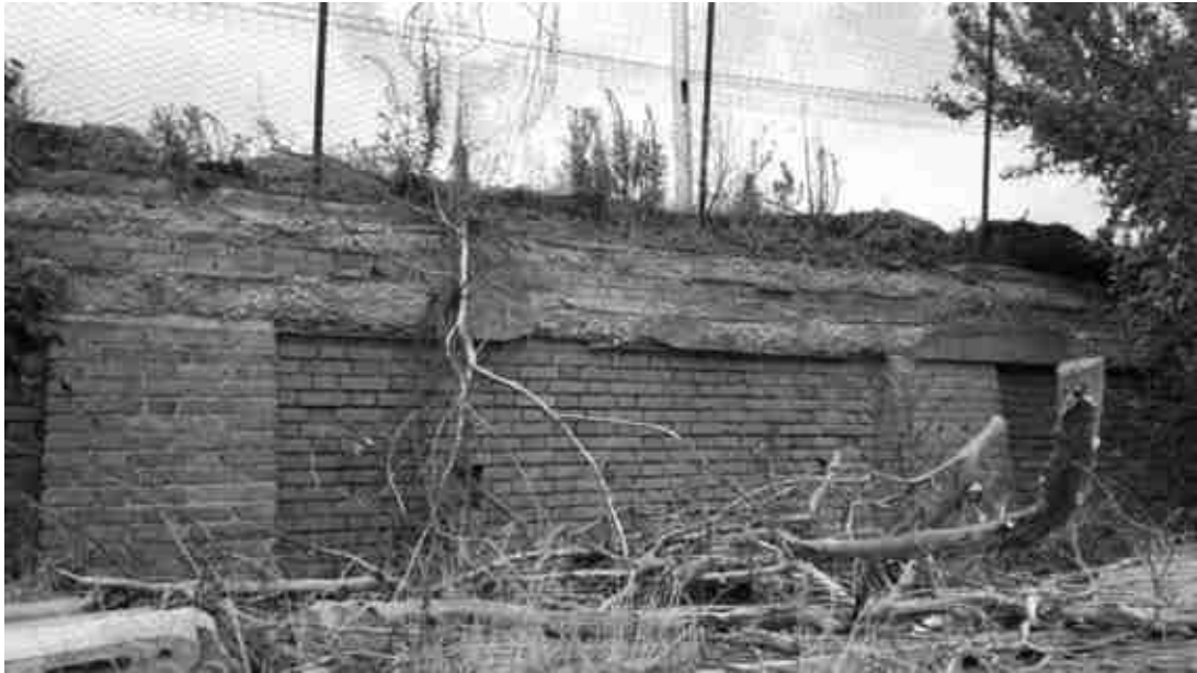
FOTO 41 – Porzione di muro di contenimento visibile tra la vegetazione ed i tralci di vigneto
