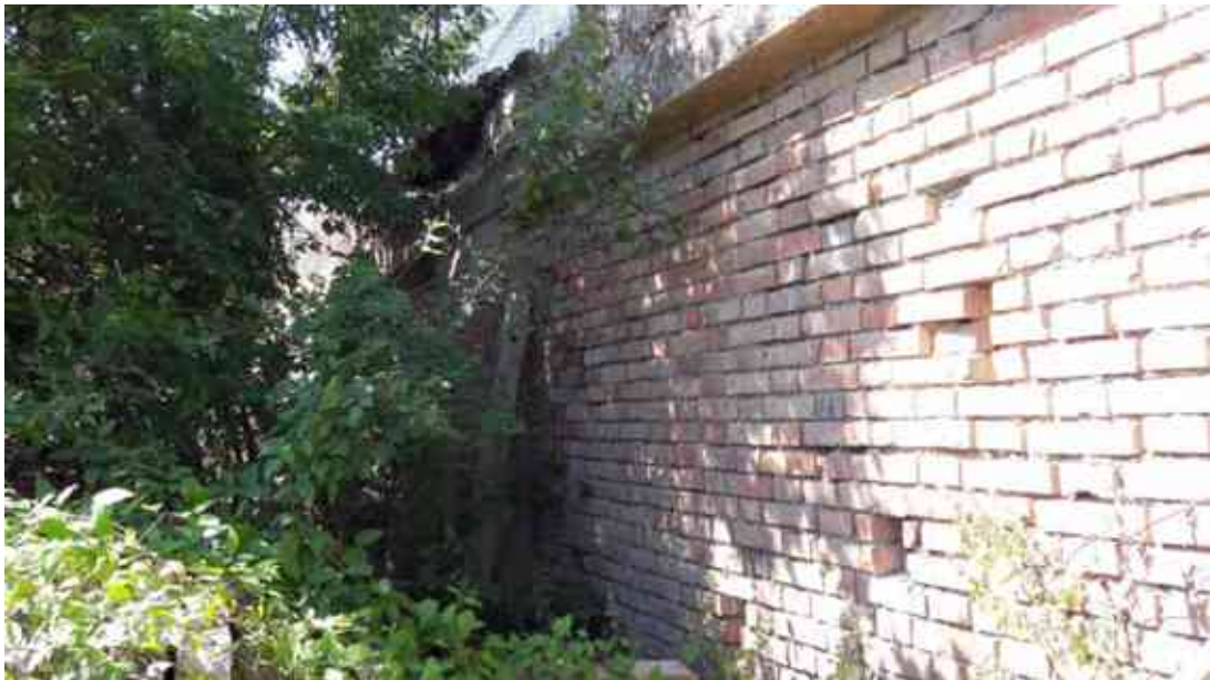
FOTO 44 – Porzione di muro di contenimento visibile tra la vegetazione ed i tralicci di vigneto
