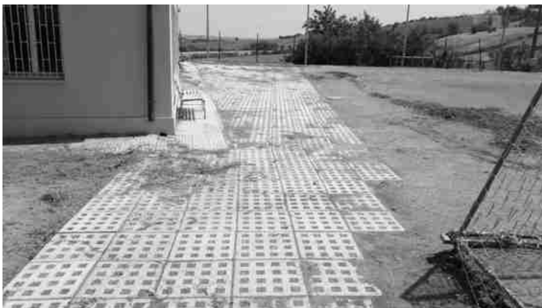
FOTO 53 – Pavimentazione di collegamento ingresso-spogliatoi
