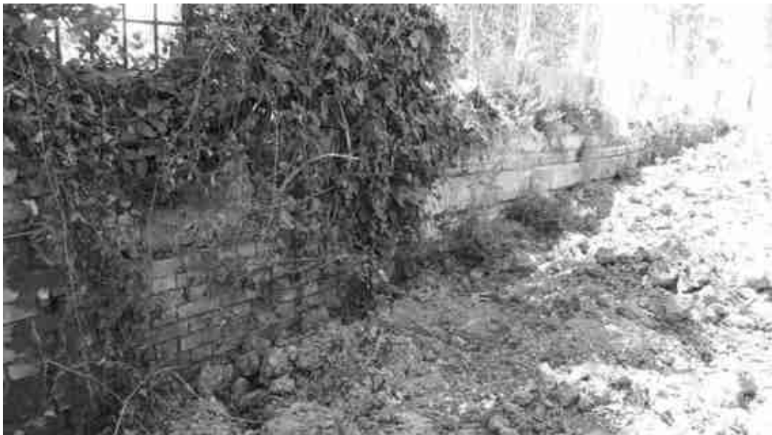
FOTO 24 – Muretto di contenimento lato nord
