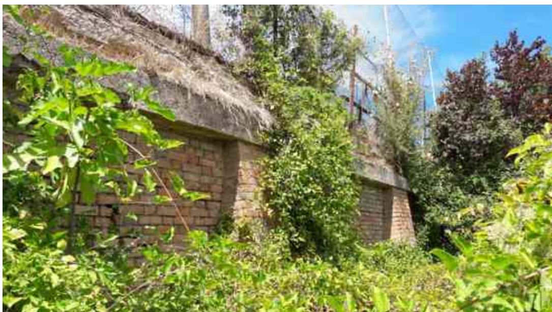
FOTO 39 – Porzione di muro di contenimento visibile tra la vegetazione ed i tralicci di vigneto
