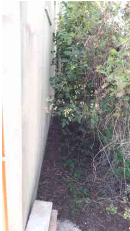
FOTO 66 – Retro magazzino-locale caldaia
