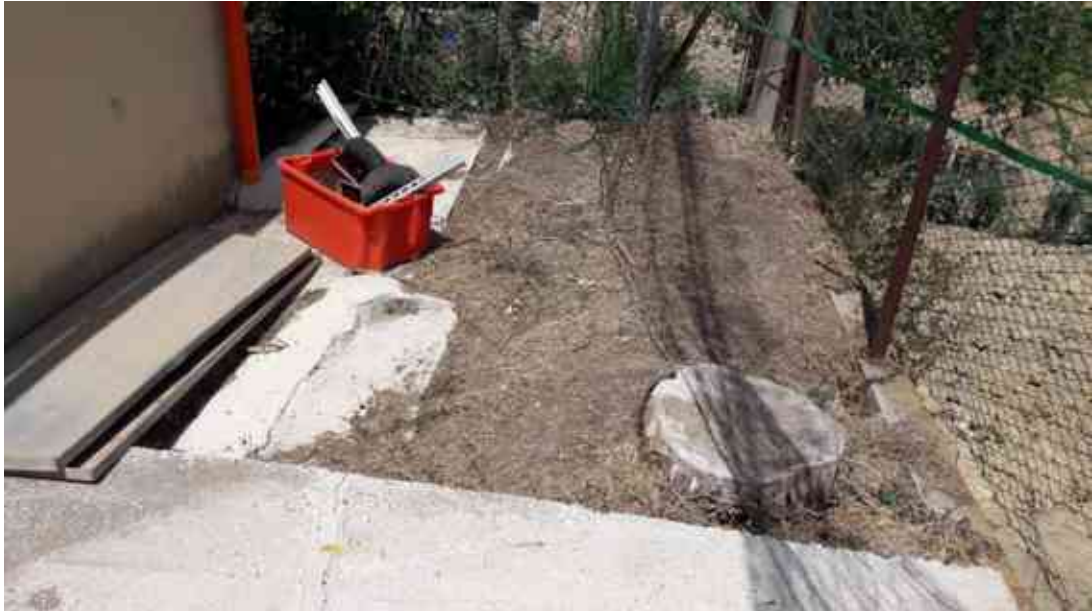
FOTO 65 – Lato magazzino-locale caldaia
