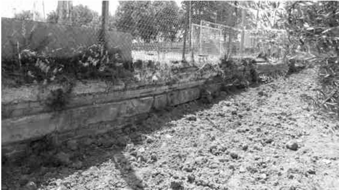
FOTO 23 – Muretto di contenimento lato nord
