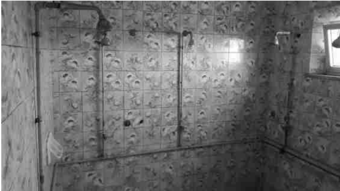
FOTO 81 – Wc spogliatoio arbitri
