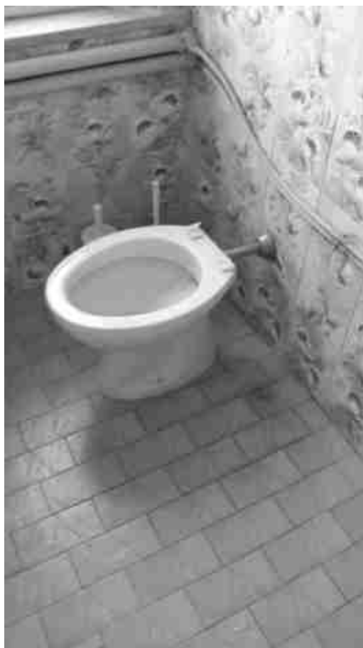
FOTO 78 – Wc spogliatoio arbitri
