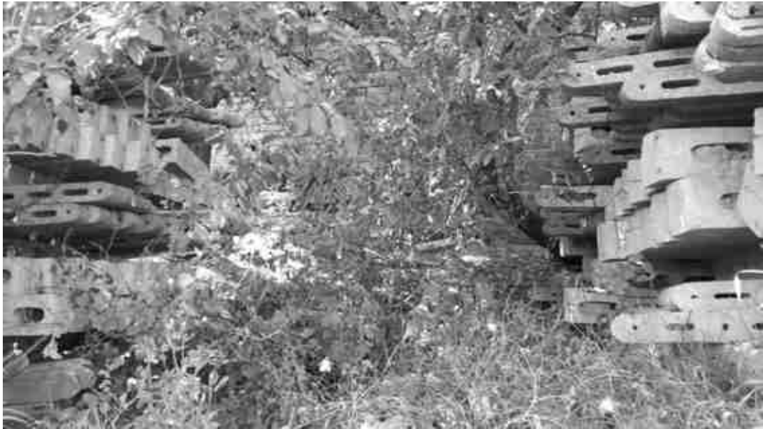
FOTO 37 – Porzione di muro di contenimento visibile tra la vegetazione ed i tralici di vigneto
