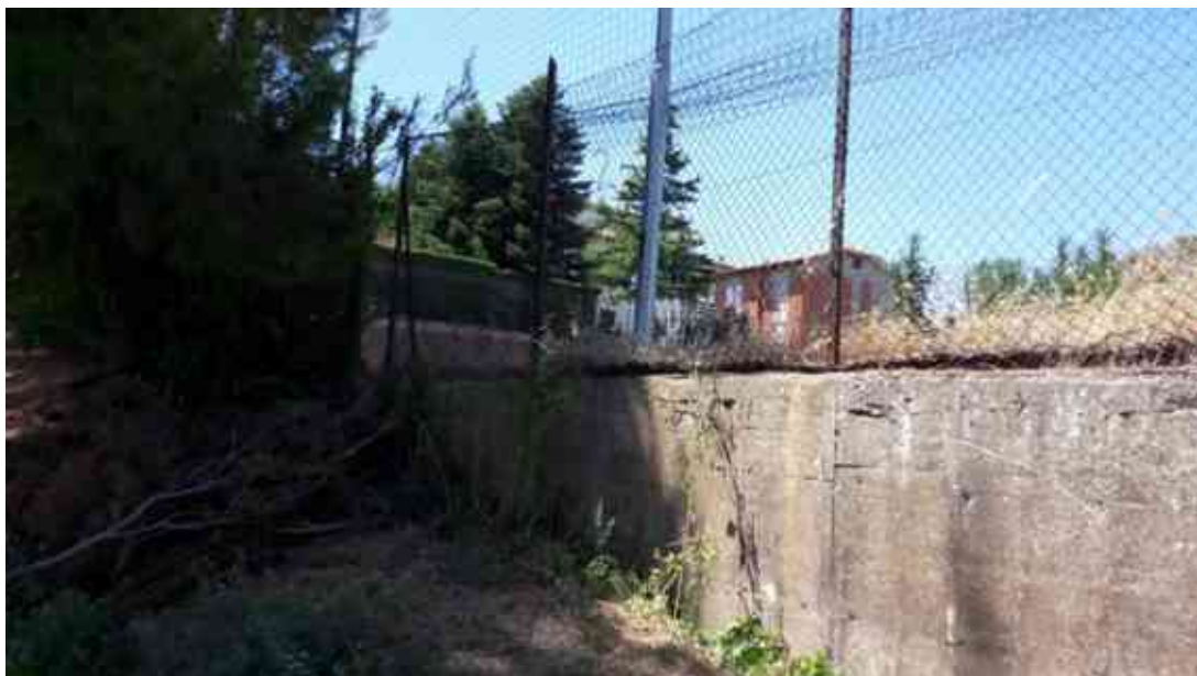
FOTO 27 – Muro di contenimento in c.a. lato est
