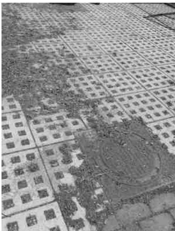
FOTO 49 – Pavimentazione di ingresso area campo sportivo e pozzetto di scarico fognatura
