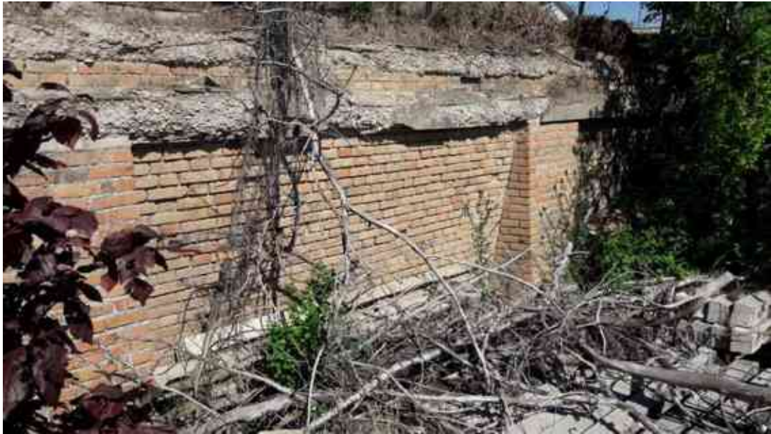
FOTO 43 – Porzione di muro di contenimento visibile tra la vegetazione ed i tralicci di vigneto
