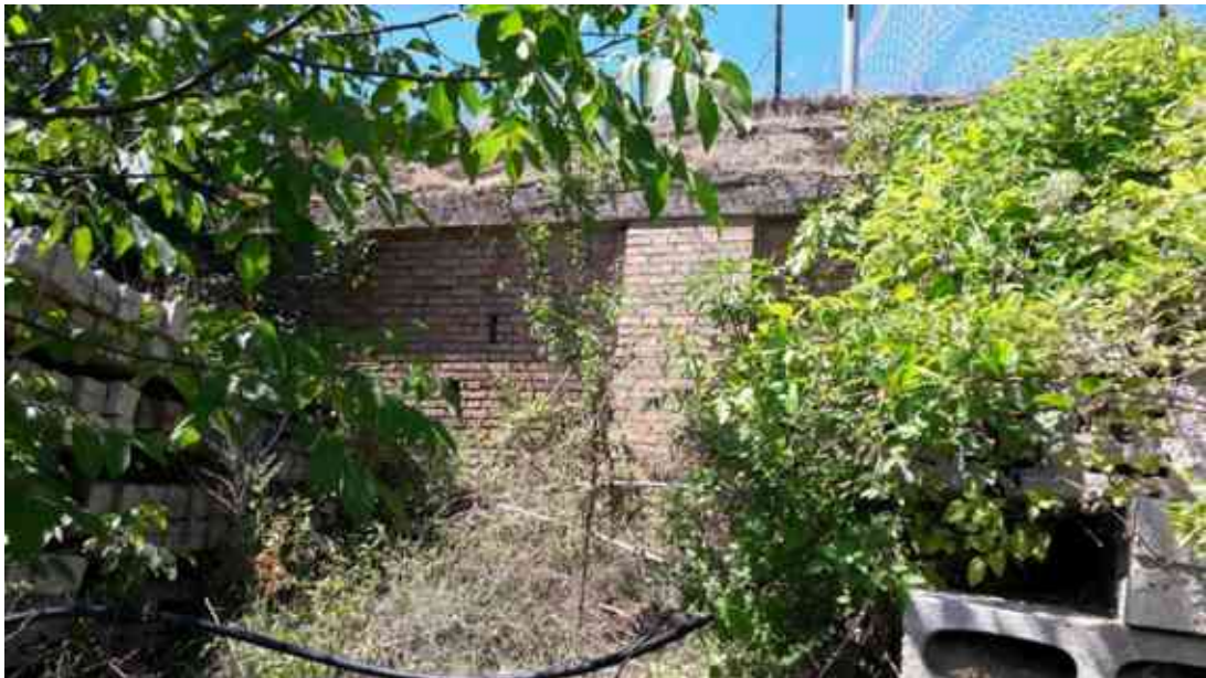
FOTO 36 – Porzione di muro di contenimento visibile tra la vegetazione ed i tralici di vigneto
