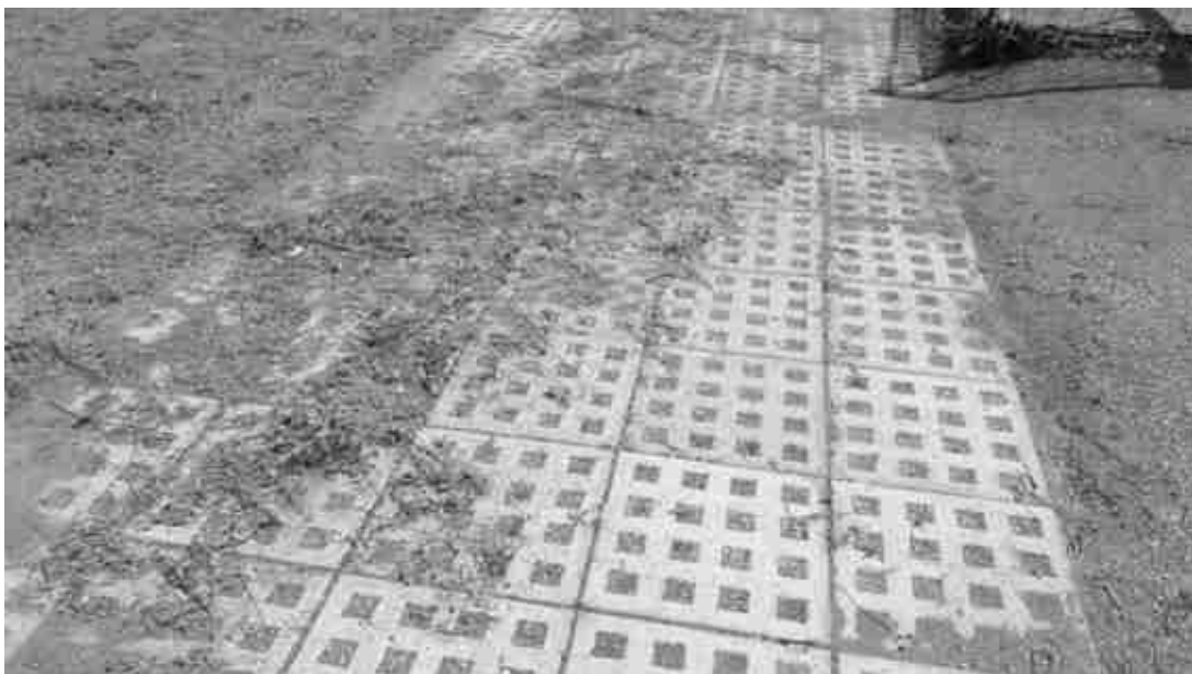
FOTO 52 – Pavimentazione di collegamento ingresso-spogliatoi
