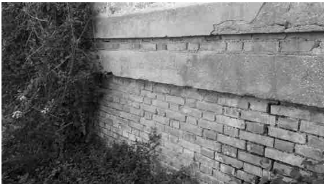
FOTO 14 – Muro di contenimento lato nord
