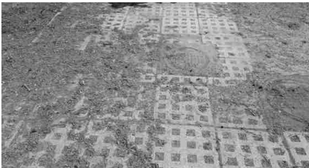
FOTO 50 – Pavimentazione camminamento e pozzetti di scarico fognatura ed elettrico
