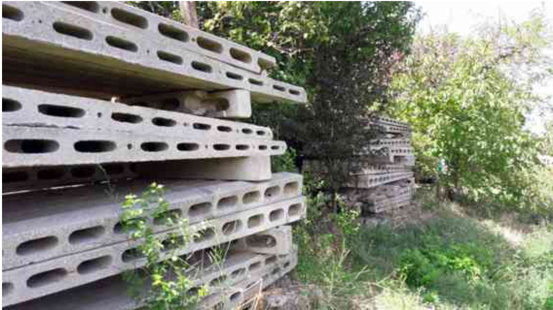
FOTO 35 – Porzione di muro di contenimento sommerso dalla vegetazione e da tralici di vigneto
