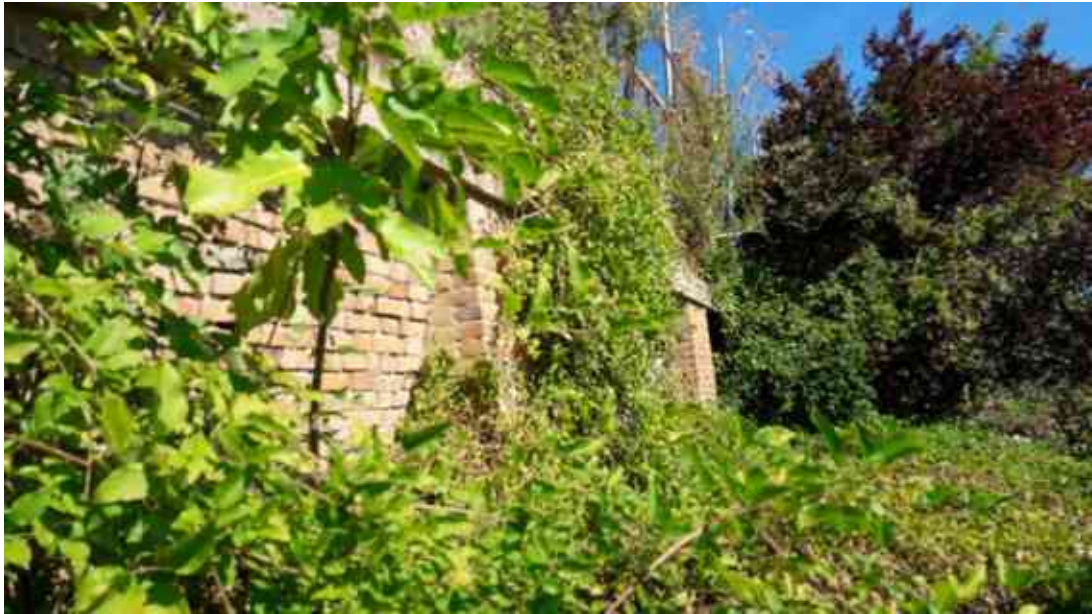
FOTO 45 – Porzione di muro di contenimento visibile tra la vegetazione ed i tralicci di vigneto
