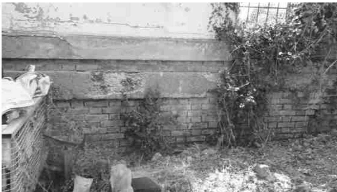
FOTO 18 – Muro di contenimento lato nord – retro spogliatoi
