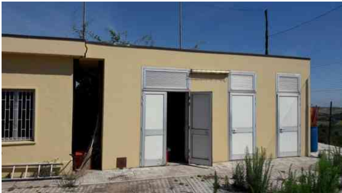
FOTO 63 – Fronte magazzino-locale caldaia
