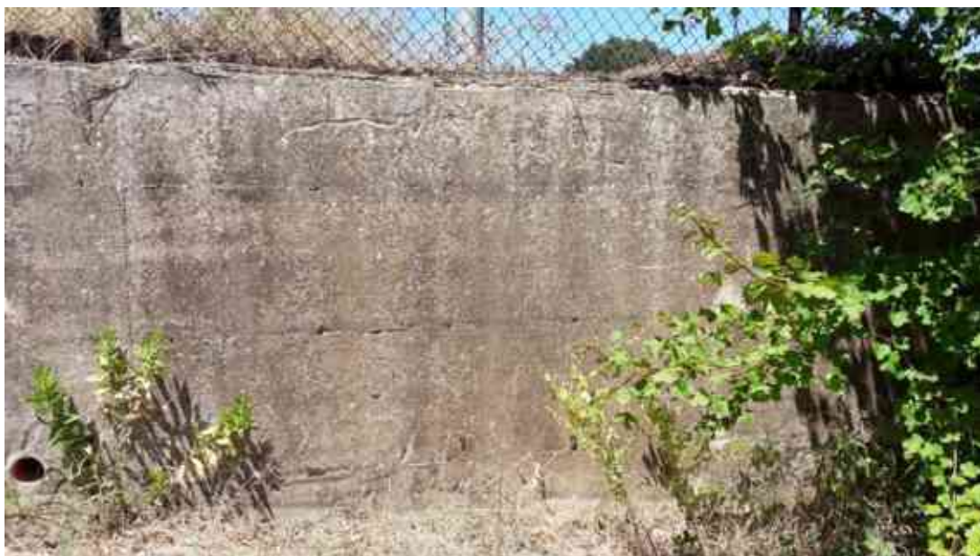
FOTO 28 – Muro di contenimento in c.a. lato est
