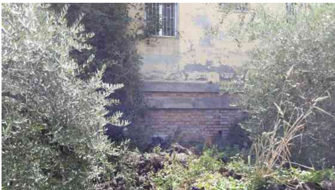
FOTO 15 – Muro di contenimento lato nord – retro spogliatoi
