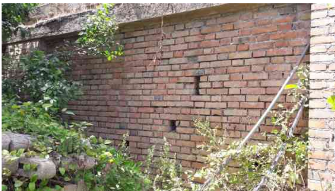
FOTO 40 – Porzione di muro di contenimento visibile tra la vegetazione ed i tralicci di vigneto
