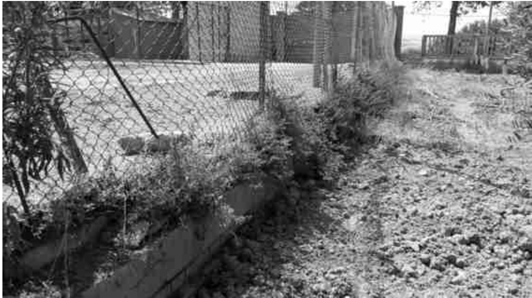
FOTO 25 – Muretto di contenimento lato nord
