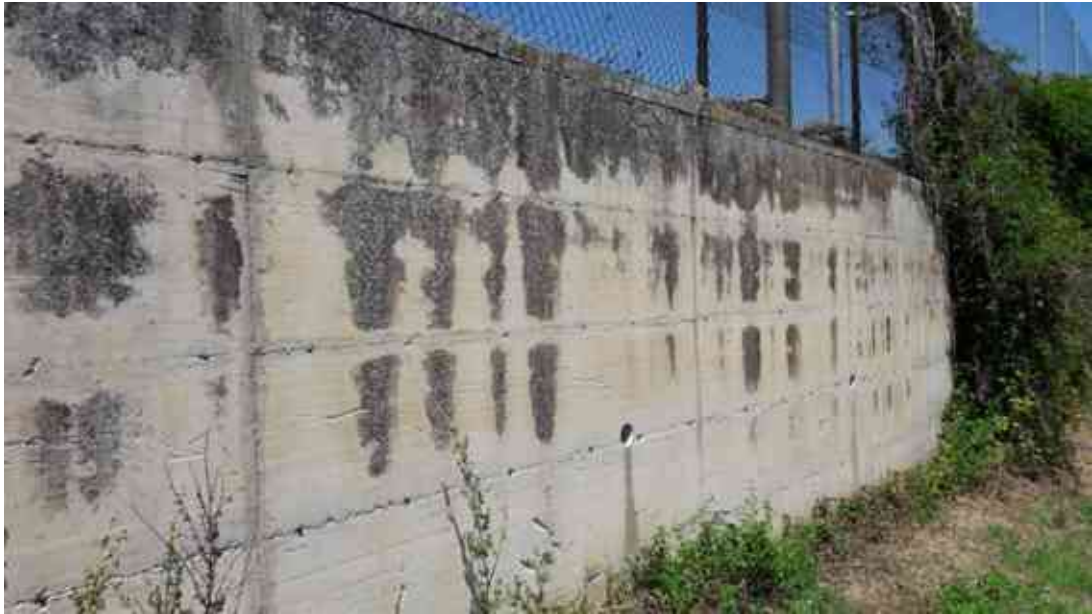
FOTO 29 – Muro di contenimento in c.a. lato est
