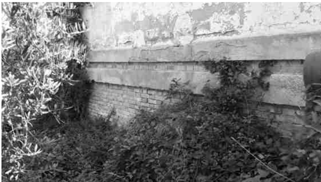
FOTO 17 – Muro di contenimento lato nord – retro spogliatoi
