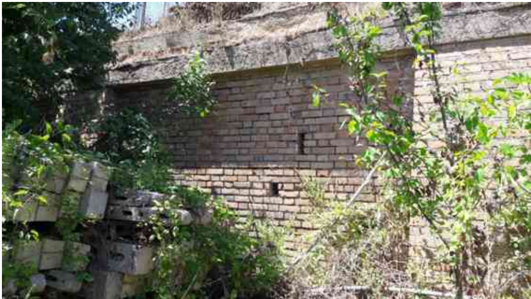
FOTO 38 – Porzione di muro di contenimento visibile tra la vegetazione ed i tralici di vigneto
