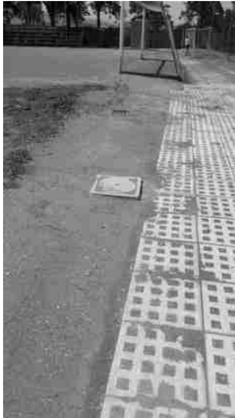
FOTO 57 – Pavimentazione esterna e linea di porta
