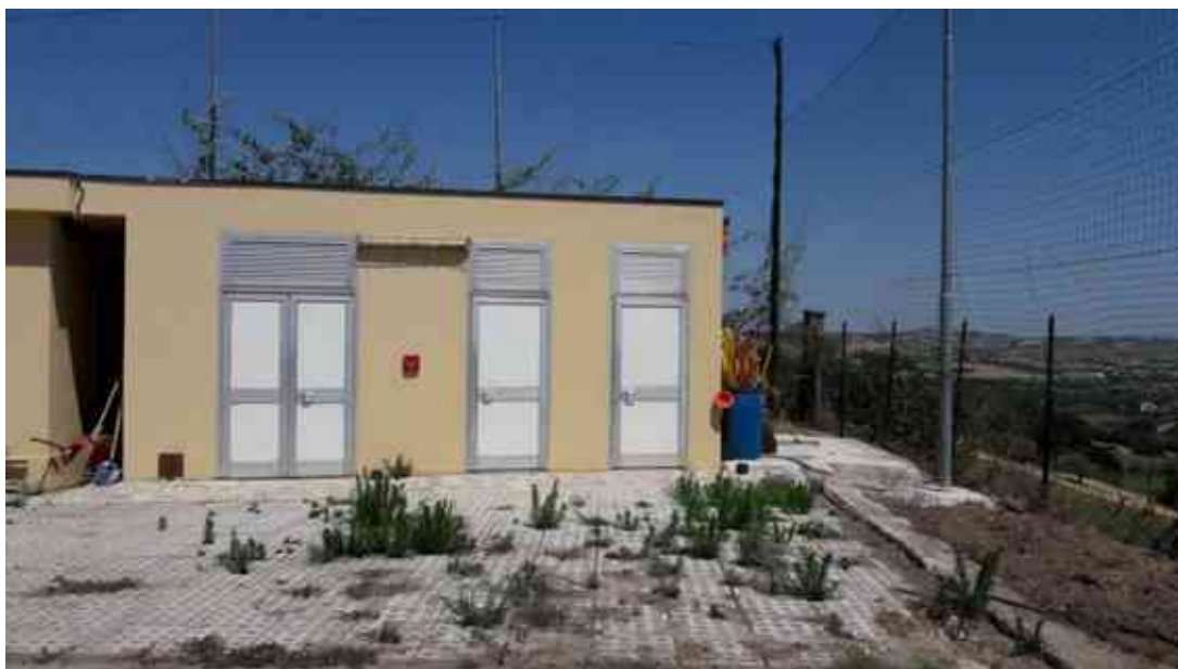
FOTO 62 – Fronte magazzino-locale caldaia
