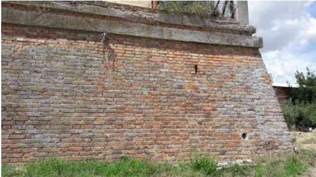
FOTO 3 – Angolo muro di contenimento lato est
