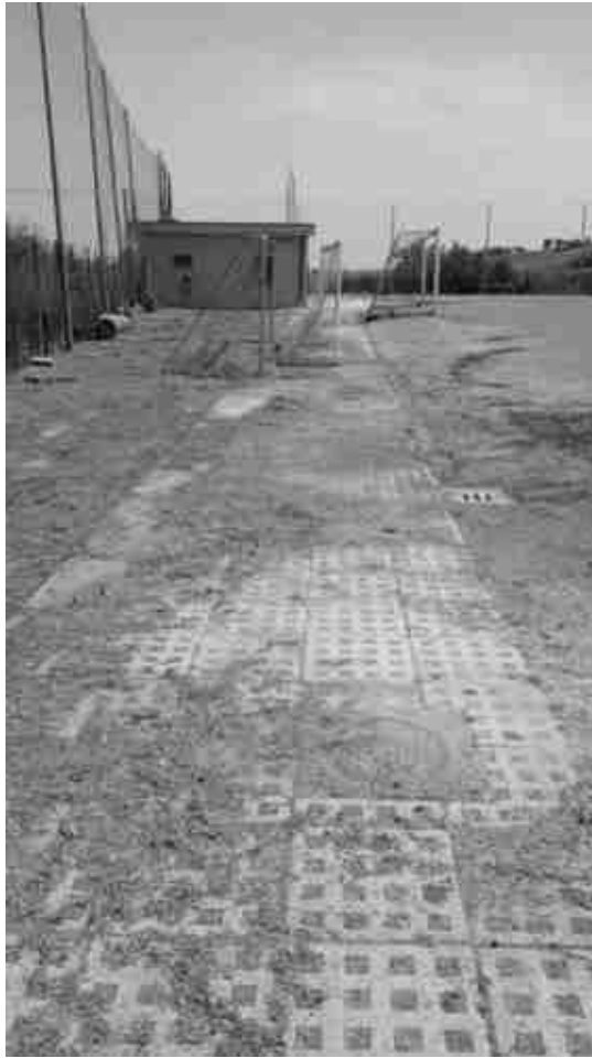
FOTO 51 – Pavimentazione di collegamento ingresso-spogliatoi
