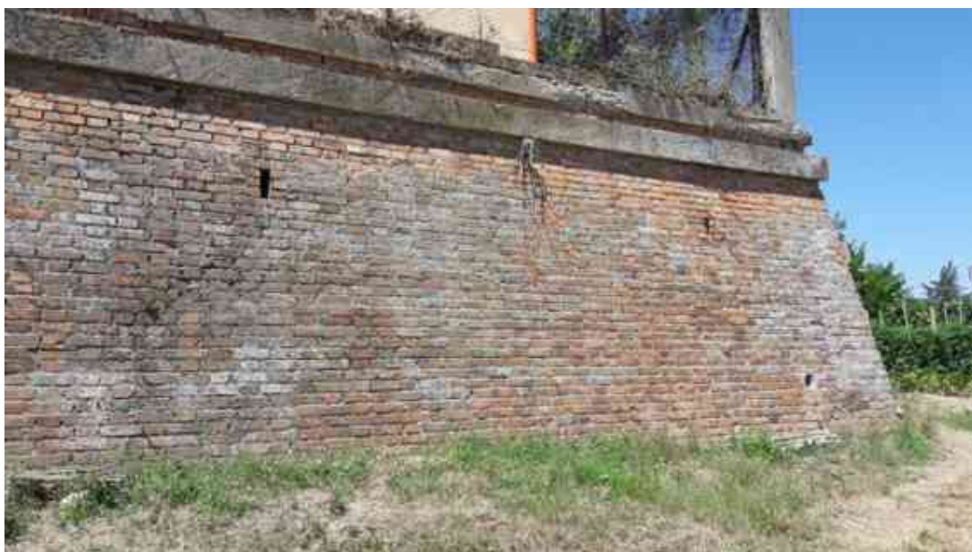
FOTO 5 – Angolo muro di contenimento lato est
