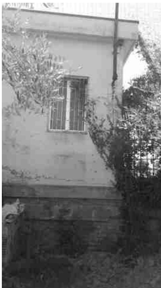
FOTO 22– Muro di contenimento lato nord – retro spogliatoi
