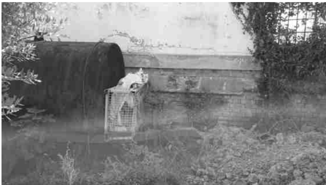
FOTO 21 – Muro di contenimento lato nord – retro spogliatoi
