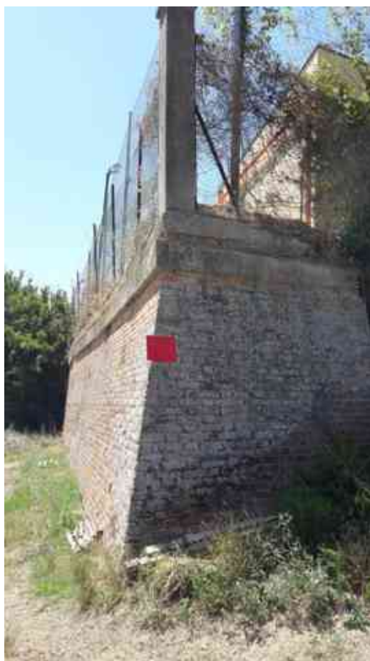
FOTO 11 – Muro di contenimento angolo nord-est
