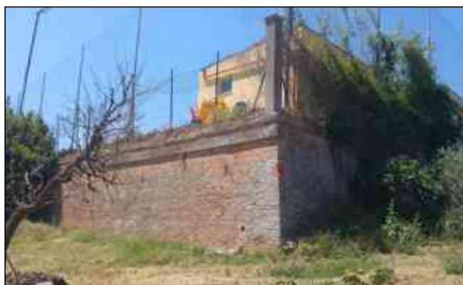
Foto cop.: Muro oggetto di manutenzione.
