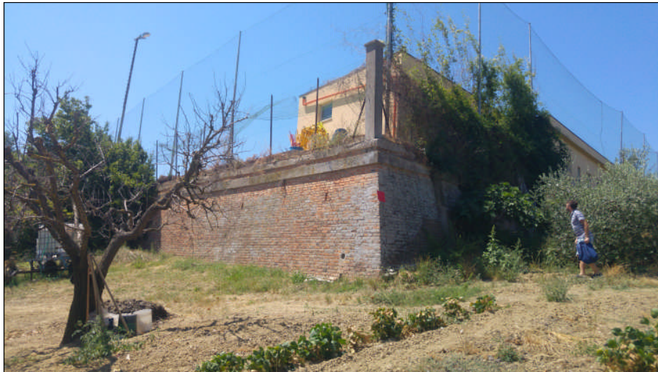
Foto 1: Particolare del muro da risistemare e del manufatto soprastante oggetto di manutenzione.
